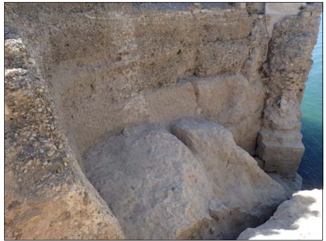
Foto 22. Vista del tercer fossat des de l'E. Al fons, s'observa el retall 1006 que delimita el lateral O d'aquesta estructura negativa.
