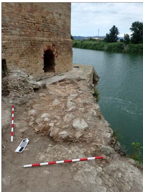
Figura 15| Vista des del S de les fonamentacions de la torre de la celòquia (3009).
