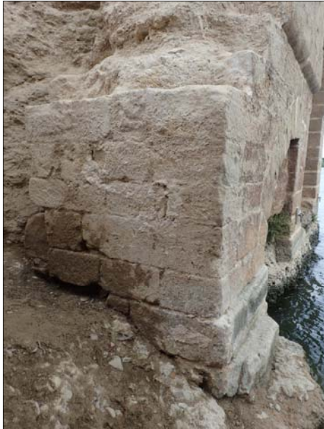
Foto 13. Cantonada de l'estructura carreuada 1037. La seva base s'adapta a la irregularitat del substrat geològic.
