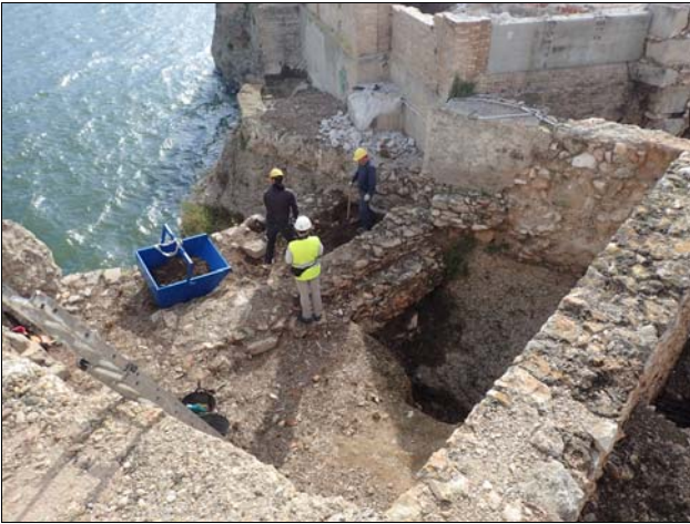
Foto 1. Inici dels treballs d'excavació. Eliminació de l'estrat superficial (1001).
