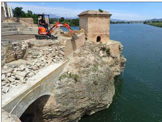
Foto 41. Desmuntatge amb mitjans mecànics del mur de maó 3003 (molí Escrivà).
