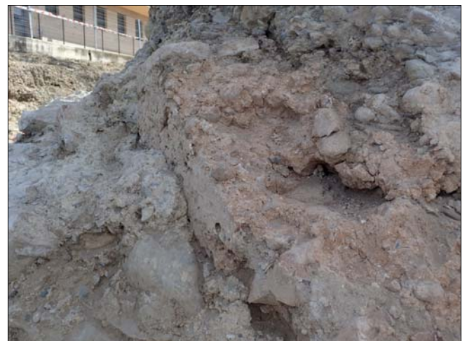
Foto 52. Detall de la cara exterior del mur de tàpia 3017. S'observa com se li adossa el rebliment en morter de calç 3007.
