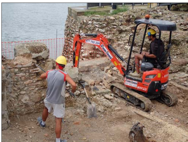
Foto 43. Tasques de desmuntatge manual de l'estructura 3001 (a l'esquerra) i desmuntatge mecànic de 3002 (a la dreta).
