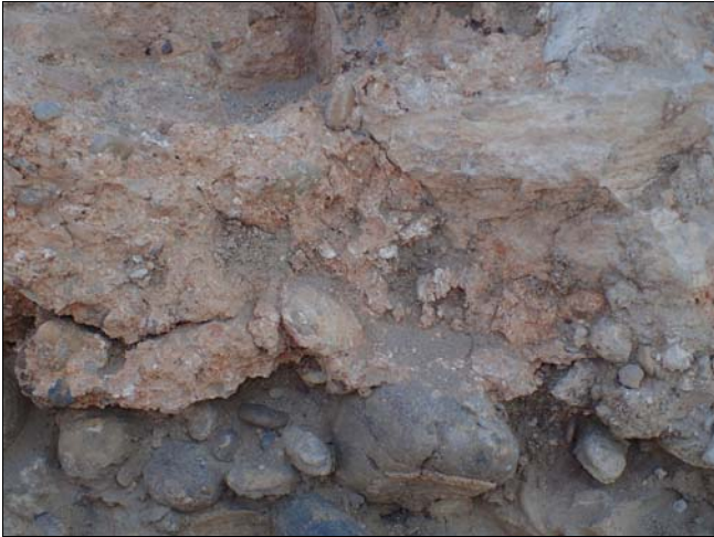
Foto 53. Detall dels components constructius de l'estructura de tàpia 3017: argila de color rosat, petits nòduls de guix i graves fines de riu.
