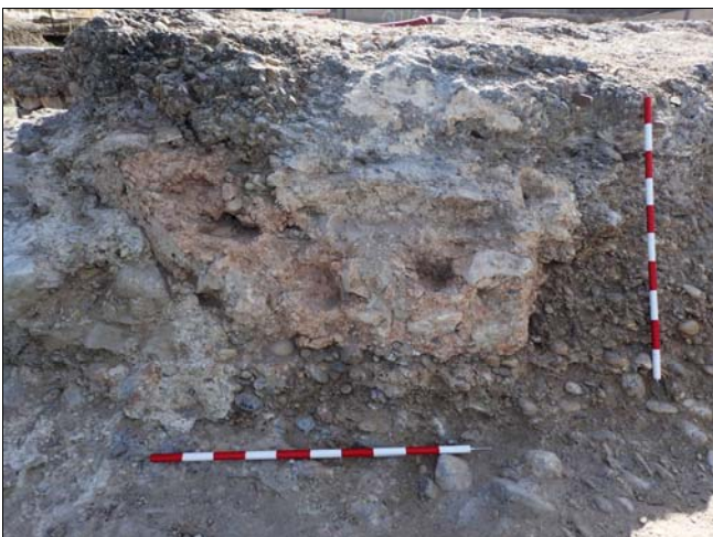
Foto 51. Restes de l'estructura en tàpia (3017) documentada a l'angle de la contraescarpa del fossat (vista des del NE).
