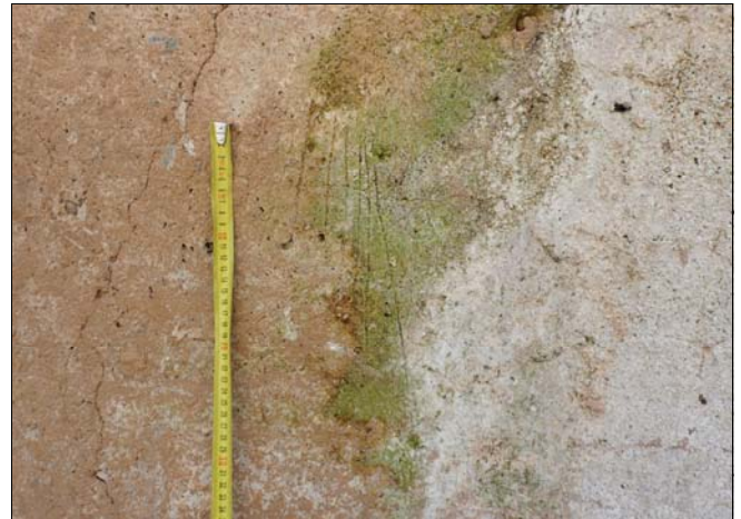
Foto 32. Detall del grafit gravat al revestiment de l'interior de la volta 2011.
