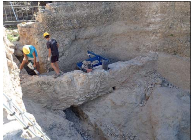
Foto 16. Procés de desmuntatge del mur de paredat de morter de calç 1008.
