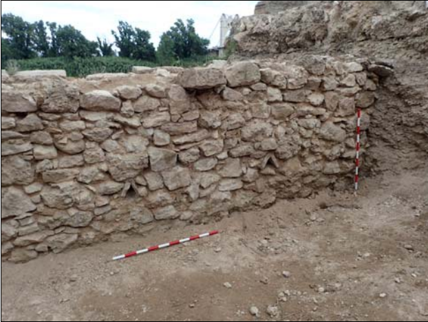
Foto 7. Parament interior del mur 1002 proveït d'orificis triangulars de drenatge.
